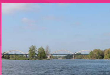
Pont de Muides - Loire
